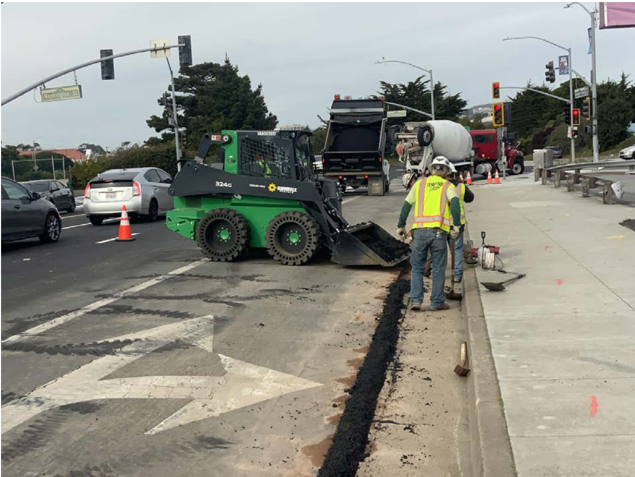
Conduit Installation
